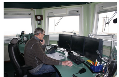
De zeeverkeerspost bovenin de toren.
